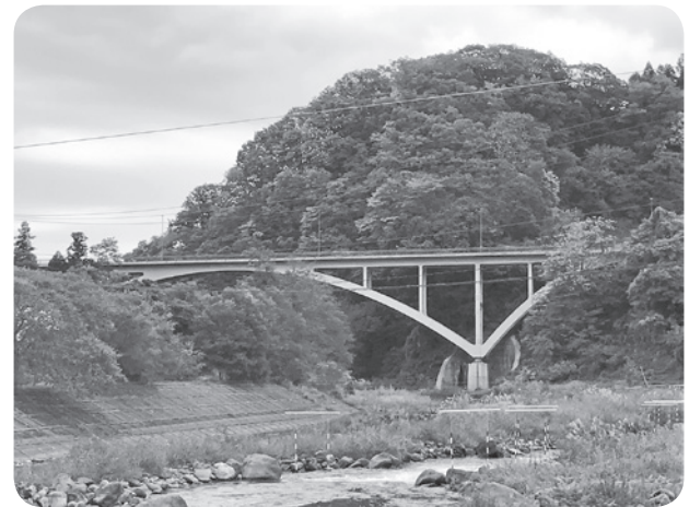
こちらの橋に親柱を施行いたしました。
